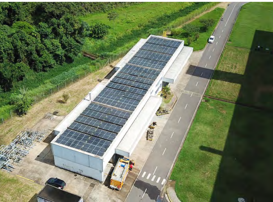
Prédio “verde” da Mercedes-Benz em Juiz de Fora, MG: placas solares no teto.
